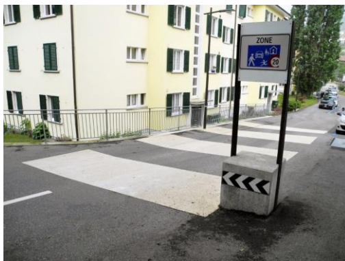
Entrée zone de rencontre, rue Marie-de-Nemours à Neuchâtel
