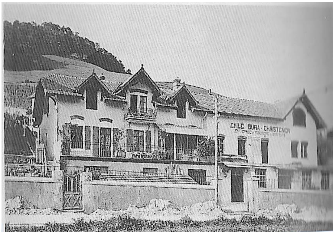
Fig. 45 La Menuiserie d'Emile Bura vers 1900 au début de la rue des Draizes.
